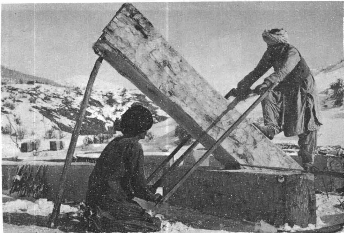
152 - Sawing of wood in the province of Paktya - Sciage du bois dans la province de Paktya
